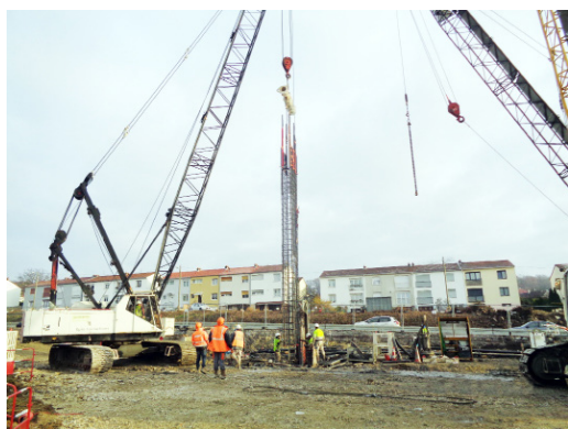
Travaux sur la VR52 à Marange-Silvange
